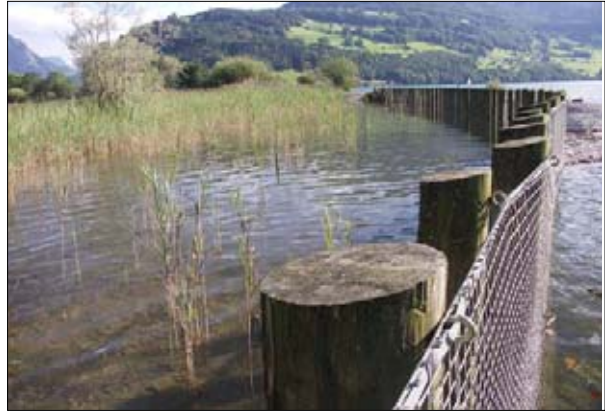
Geschwemmselzaun und Wellenschutz vor dem Naturschutzgebiet Hopfräben. Blick Richtung Südwesten (nach Treib).
