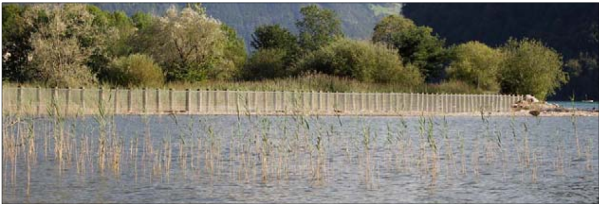
Geschwemmselzaun und vorgelagerter Wellenschutz (Kiesschüttung) vor den Gräben des Naturschutzgebietes Hopfräben. Im Vordergrund lockerer Schilfbestand bei Transekt 15.
