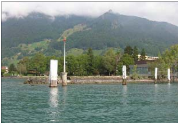
Ufersituation Transekte 49 - 50. Hafenmauer auf der Westseite des Föhnhafens Brunnen. Landebucht für die grossen Kursschiffe. Hintergrund rechts: Hallenbad Brunnen.
