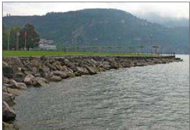
Ufersituation Transekt 51. Uferbefestigung mit Blockschüttung. Linker Bildrand: Südliche (seeseitige) Hafenmole des Föhnhafens Brunnen.
