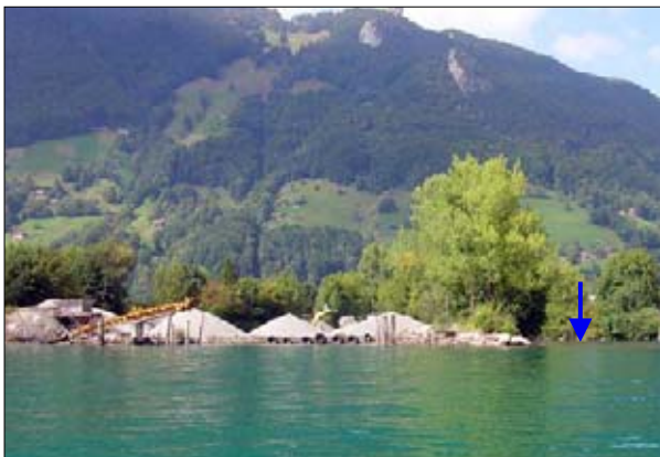
Ufersituation Transekte 38 - 41 (Hafenanlage für Kiesumschlag). Rechts: Muotamündung (Pfeil).
