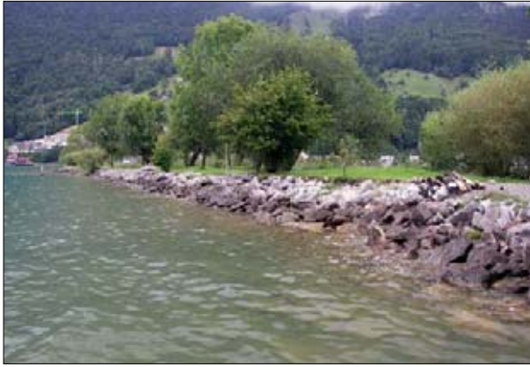
Uferschüttung mit Blockwurf und Kies auf der südwestlichen Seite des Naturschutzgebietes Hopfräben. Bereich der Transekte 20 - 34 (= Abschnitt des Kiesabbaus in der Flachwasserzone). Bild links: Nordwestlicher Bereich der vorgelagerten Uferschüttung. Bild rechts: Südöstlicher Abschnitt. Ganz rechts Bootshaus vor dem Campingplatz bei Transekt 34.
